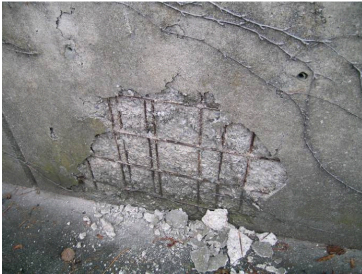
Abbildung 3-3: Mögliche Begleitschäden bei AAR Oben: Abplatzungen mit Korrosionsschäden Rechts: Bauteilversatz bei AAR-Schäden
