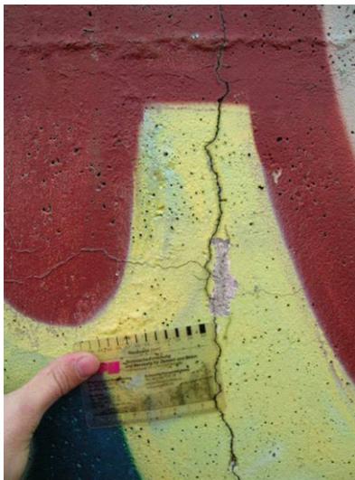
Abbildung 5-2: Gerissene starre Beschichtung auf AAR-geschädigtem Beton.
