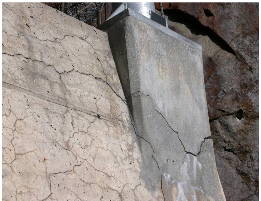
Abbildung 6-9: Diagonal verlaufende Risse in einer verankerten Stützmauer.
