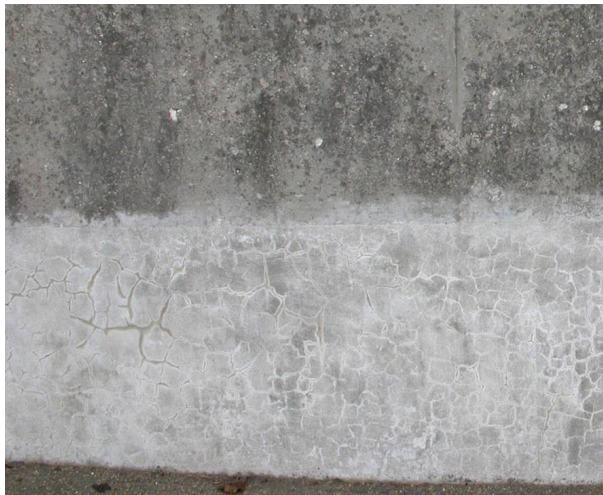
Abbildung 5-2: Gerissene starre Beschichtung auf AAR-geschädigtem Beton.
