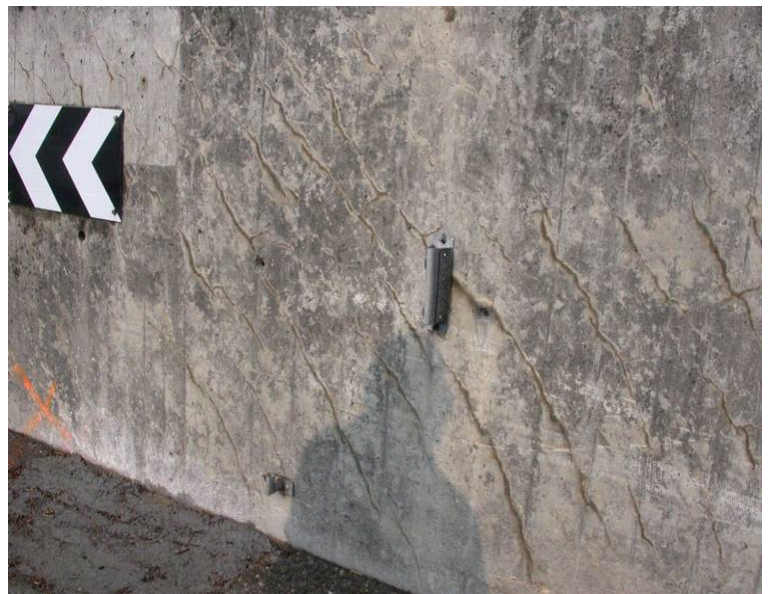
Abbildung 6-9: Diagonal verlaufende Risse in einer verankerten Stützmauer.
