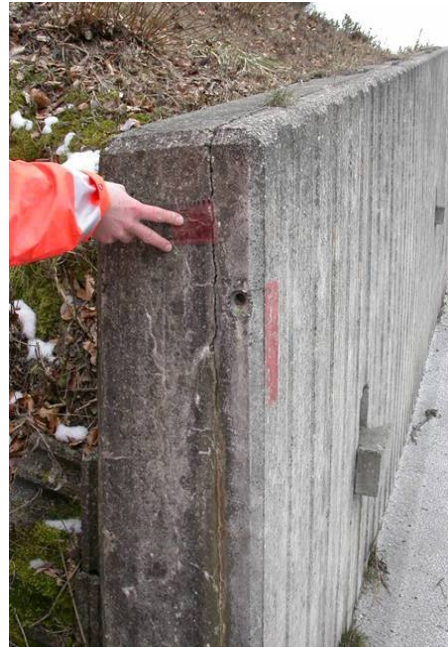
Abbildung 6-12: Alkalireaktiver Betonkern mit einem Vorbeton, der sich vertikal ablöst (links Seitenansicht, rechts Draufsicht).
