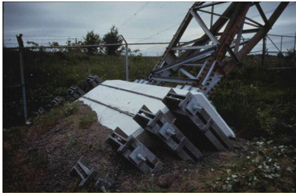
Abbildung 5-6 (oben): Verstärkte Fundation eines Hochspannungsleitungsmastes mit Stahlklammern (Durand 2000).
