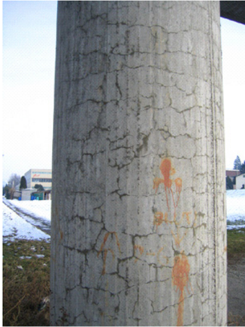
Abbildung 6-28: Oben rechts: Ausgeprägtes Rissnetz mit dunklen Ausblühungen bei einem runden Pfeiler
