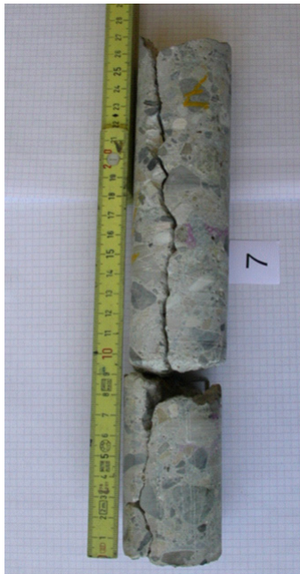
Abbildung 6-13: Durchgehender Riss parallel und Schalenriss senkrecht zur Bohrernachse bei einer dünnwandigen Stützmauer.
