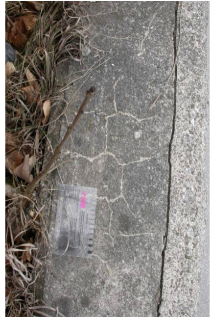
Abbildung 6-12: Alkalireaktiver Betonkern mit einem Vorbeton, der sich vertikal ablöst (links Seitenansicht, rechts Draufsicht).
