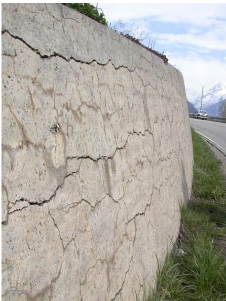
Abbildung 6-8: Horizontal verlaufende, offene Risse bei einer Stützmauer.
