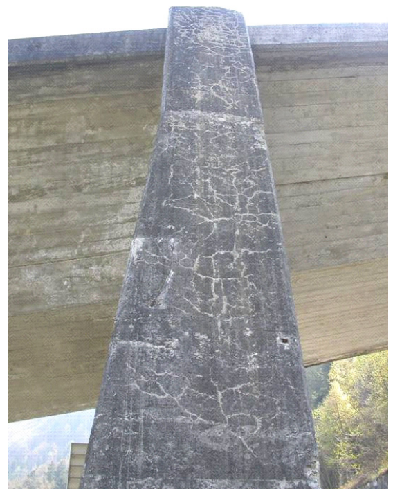
Abbildung 6-27: Stütze einer Bachüberführung über eine Strasse.
