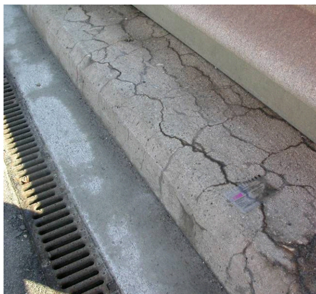
Abbildung 6-18 (rechts unten): Ausgeprägtes Rissnetz auf einer Bordüre.
